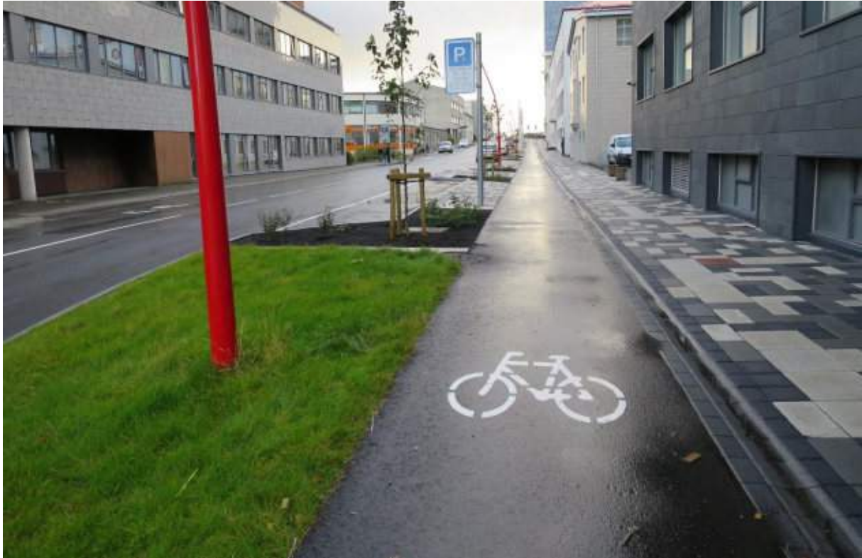
MYND 18 Hjólastígur með einstefnu aðskilinn frá göngustíg með hæðarmun. Myndin er tekin í Borgartúni. (Mynd: Erik Kærgaard).
