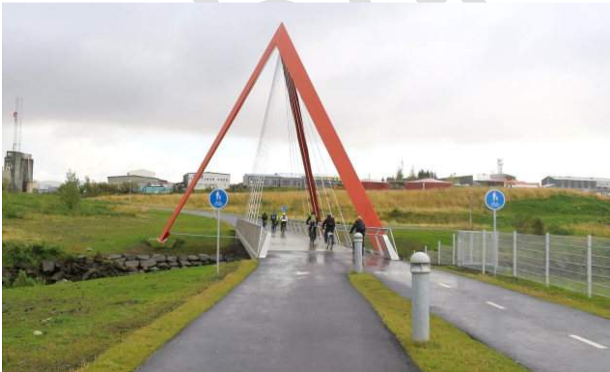
MYND 56 Óheppileg hönnun brúarhandriðs. Handrið brúar hallar inn og þregir að rými vegfarenda. Eins geta hjólréiðamenn hjólað á handriðsenda eða framhjá því, ofan í ána. Við Elliðaárósa. (Mynd: Erik Kærsgaard)
