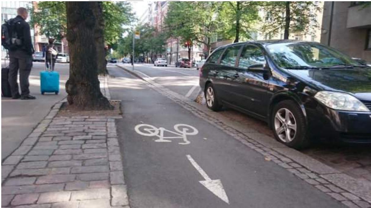
Mynd 61 Hjólastígur með einstefnu við samsíða bílastæði. Öryggisræma milli bílastæðis og hjólastígs. Helsinki Finnlandi.
