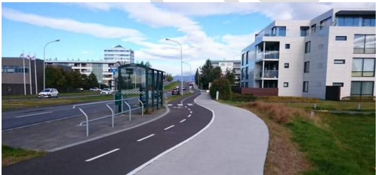
MYND 66 Hjólastígur liggur aftur fyrir biðstöð. Girðing stýrir hvar gengið er yfir hjólastíginn, milli göngustígs og biðstöðvar/bryggju.
