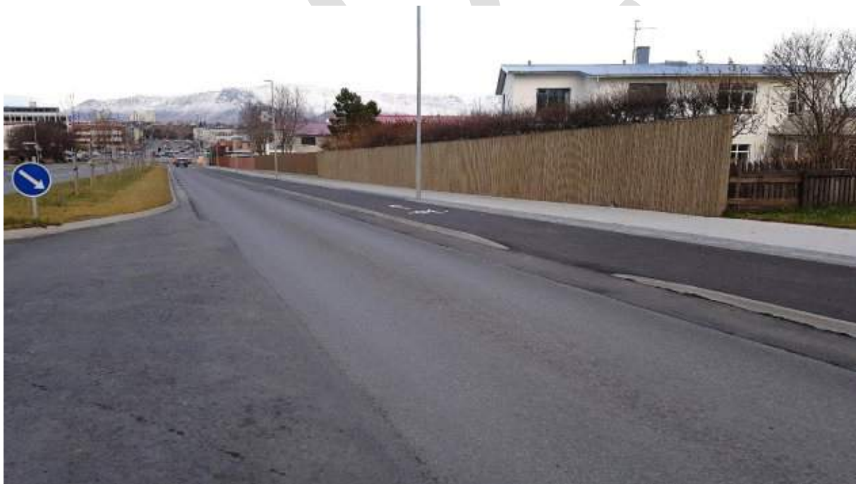
MYND 48 Niðurtekt í hjólastíg til að hleypa hjólréiðamönnum af og inn á hjólastíg. Passa þarf að þverhalli stígsins sé réttur framhjá niðurtektinni. Ef á þarf að halda er stígurinn lækkaður staðbundið.
