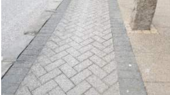
MYND 21 Hellulagður hjólastígur með fiskibeinamynstri.
