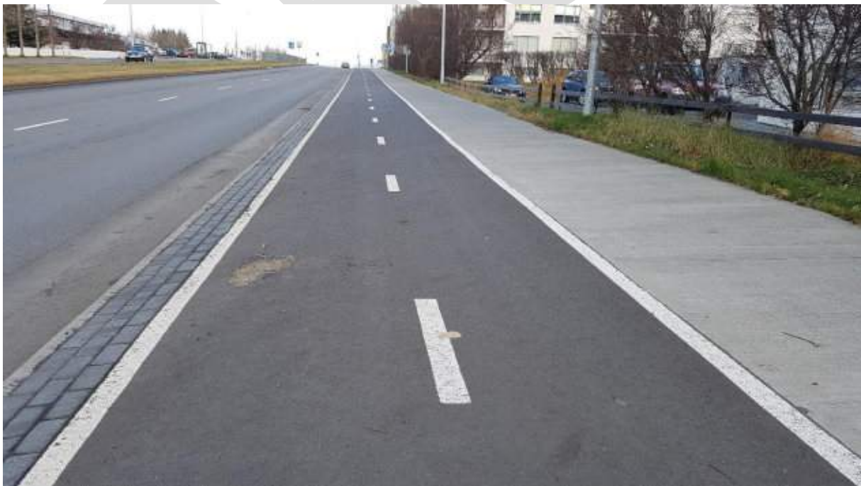
MYND 19 Hjólastígur við hlið gangstéttar aðskilnaður með mismunandi efni og hvítri málaðri línu á Háaleitisbraut. Hálfur metri frá götu að hjólastíg.
