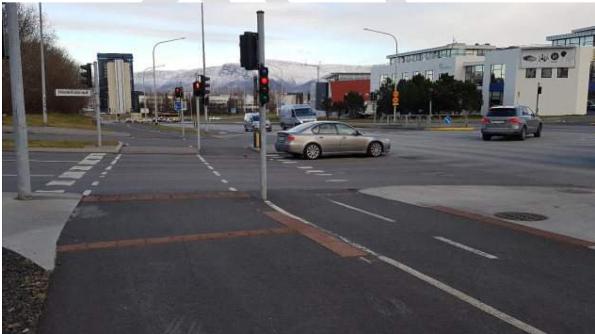
MYND 44 Ljósagatnamót þar sem er hjólastígur með tvístefnu og leið hjólreiðamanna á gatnamótunum varin.
