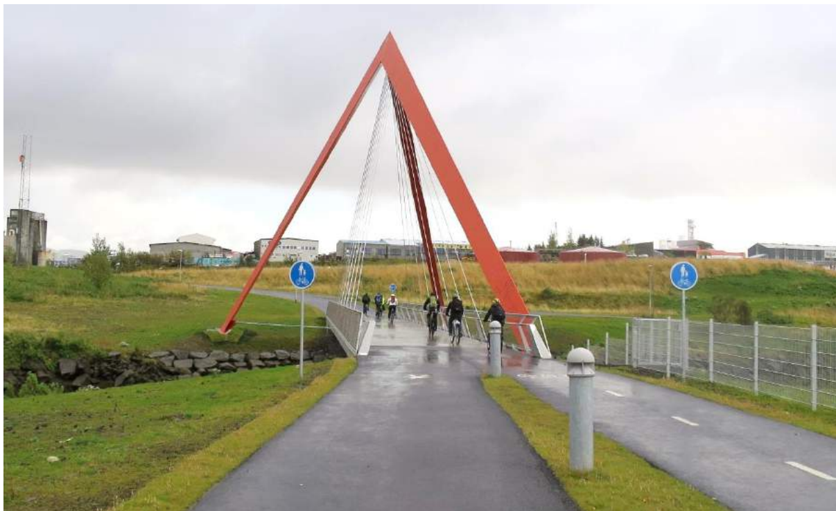
MYND 48 Óheppileg hönnun brúarhandriðs. Handrið brúar hallar inn og þrengir að rými vegfarenda. Eins geta hjóltreidamenn hjólað á handriðsenda eða framhjá því, ofan í ána. Við Elliðaárósa. (Mynd: Erik Kærsgaard)
