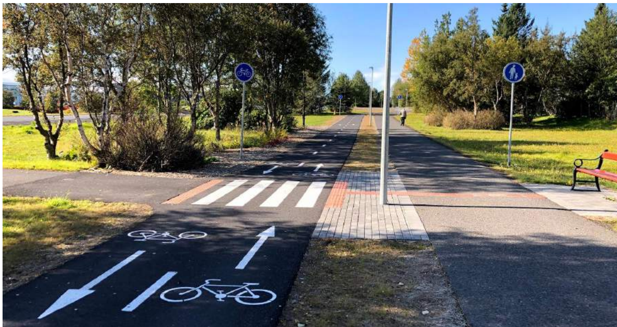
MYND 50 Gönguþverun yfir hjólastíg merkt sem gangbraut. Hér vantar gangbrautarskilti til að veita gangandi vegfarendum forgang. Áherslufletir sitthvoru megin við gönguþverunina. (Mynd: Ragnar Gauti Hauksson)
