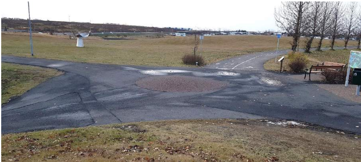
MYND 49 Hringtorg á mótum stíga. Miðeyja mótuð með lituðri steinlög sem hækkar að miðju. Lýsing mætti vera betri.
