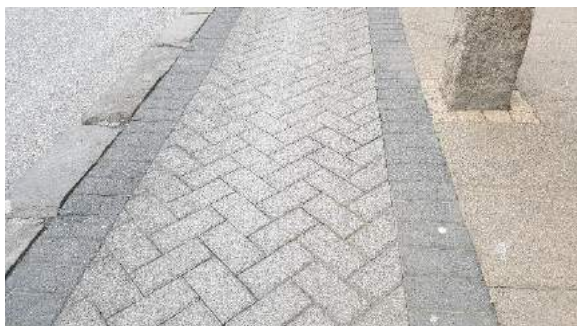
MYND 17 Hellulagður hjólastígur með fiskibeinamynstri.
