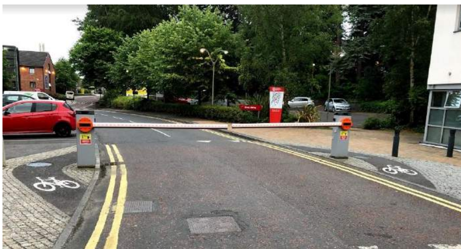
MYND 65 Hjáleið fyrir hjólandi umferð framhjá hliðum. Belfast, Norður Írlandi. (Mynd: Ragnar Gauti Hauksson)
