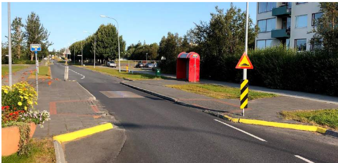
MYND 67 Koddi og þrenging við strætisvagnabiðstöð. Rofabær, Reykjavík. (Mynd: Ragnar Gauti Hauksson)
