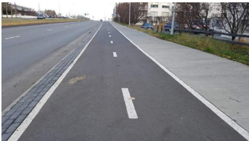
MYND 12 Hjólastígur við hlið gangstéttar á Háleitisbraut. Aðskilnaður með mismunandi efni og hvítri málaðri línu. Aðskilnaður frá götu ætti að vera meiri.
